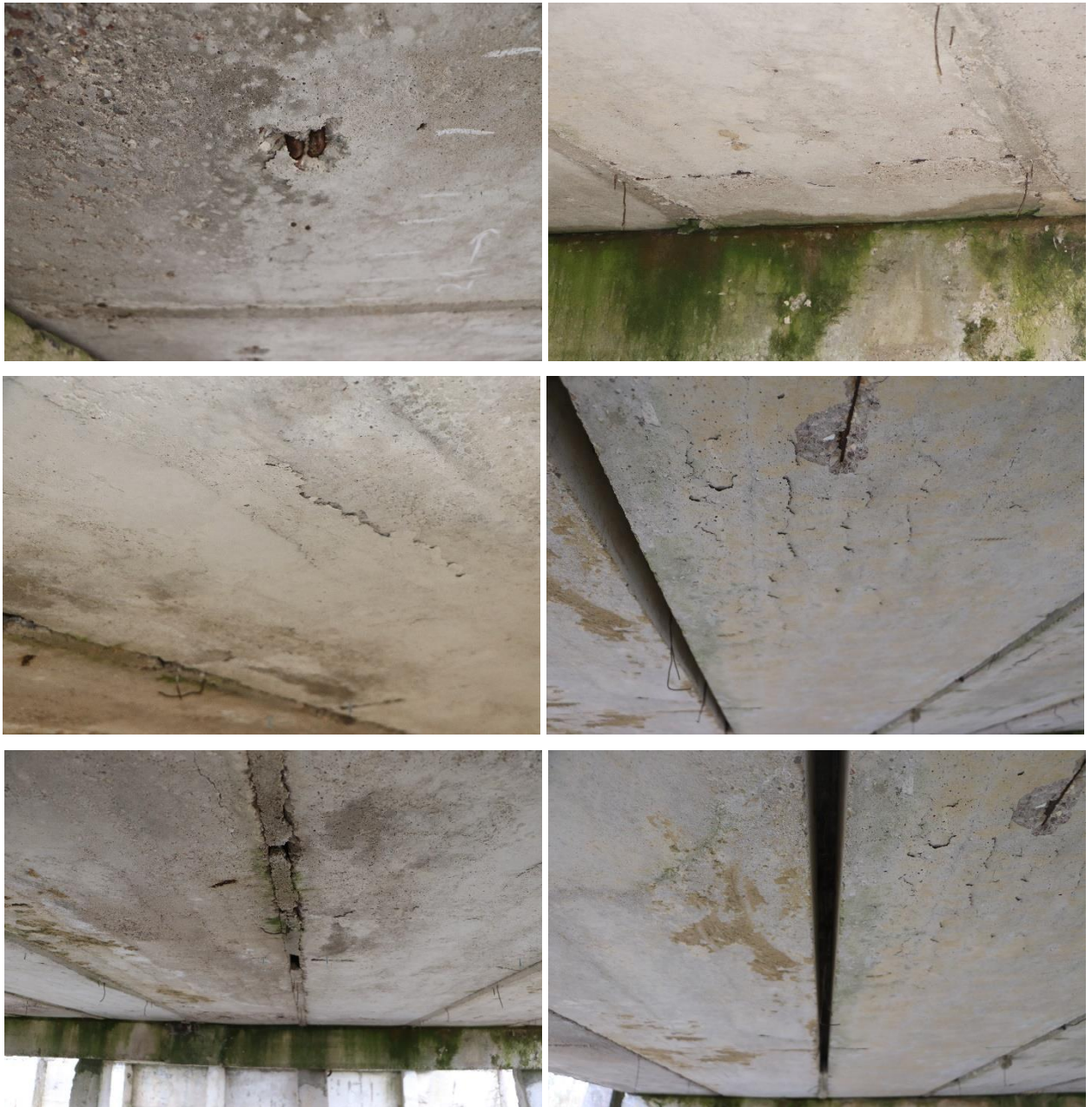
21 pav. Gelžbetoninių perdangos plokščių defektai: lokalis apsauginio sluoksnio pažaidos ir armatūros korozija, išilginiai ir įstrižieji plyšiai, porėti betono paviršiai, netinkamai užpildytos monolitinės siūlės tarp plokščių
