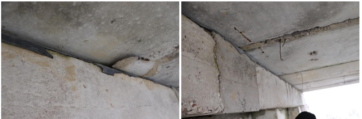
6 pav. Bitumuoto popieriaus intarpai perdangų atraminėse zonose
