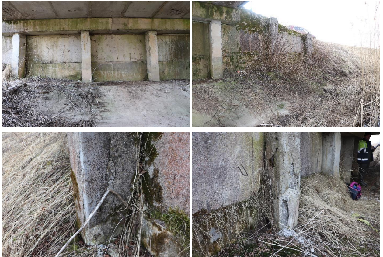
25 pav. Charakteringi ramtų atraminių sienų defektai: pažeisti apsauginiai sluoksniai, sudūlėję ir apsamoję paviršiai, betono ir armatūros korozija
