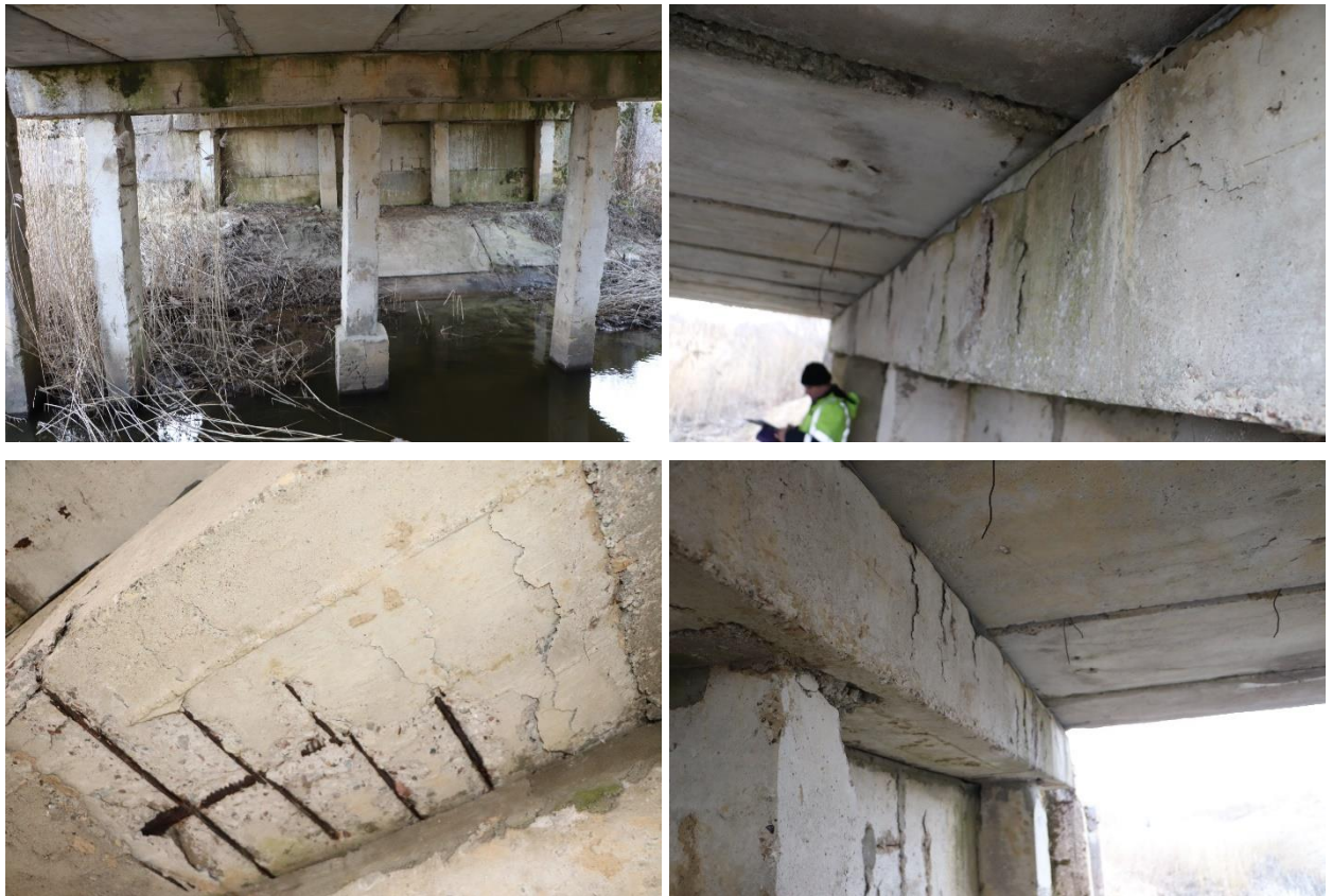
24 pav. Charakteringi ramtų defektai: pratekėjimai, nuoskėlos, pažeistas apsauginis sluoksnis, betono ir armatūros korozija
