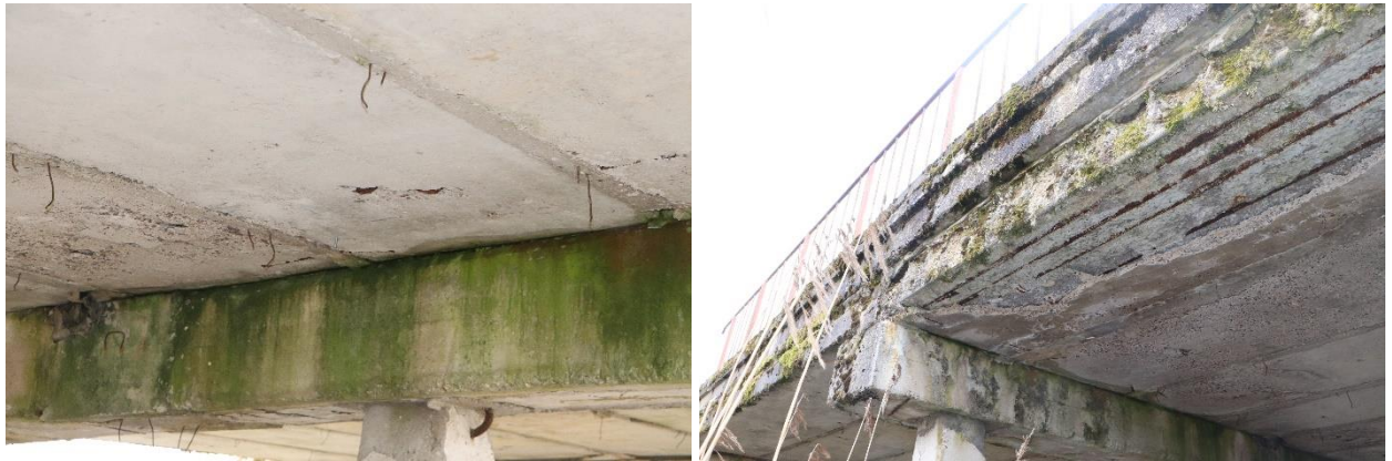
18 pav. Dėl blogos hidroizoliacijos perdangos lokaliose zonose vandens pratakų sukelta betono ir armatūros korozija
