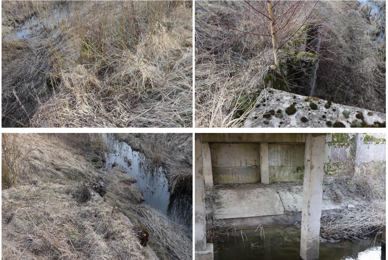
26 pav. Kūgių prietilčiuose ir po tiltu defektai: apaugę kūgių šlaitai, deformuoti ir dumbliu apnešti kūgių šlaitus stiprinančios gelžbetoninės plokštės
