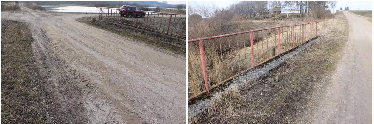
17 pav. Nelygi ir žolėmis apaugusi važiuojamosios dalies žvyro danga
