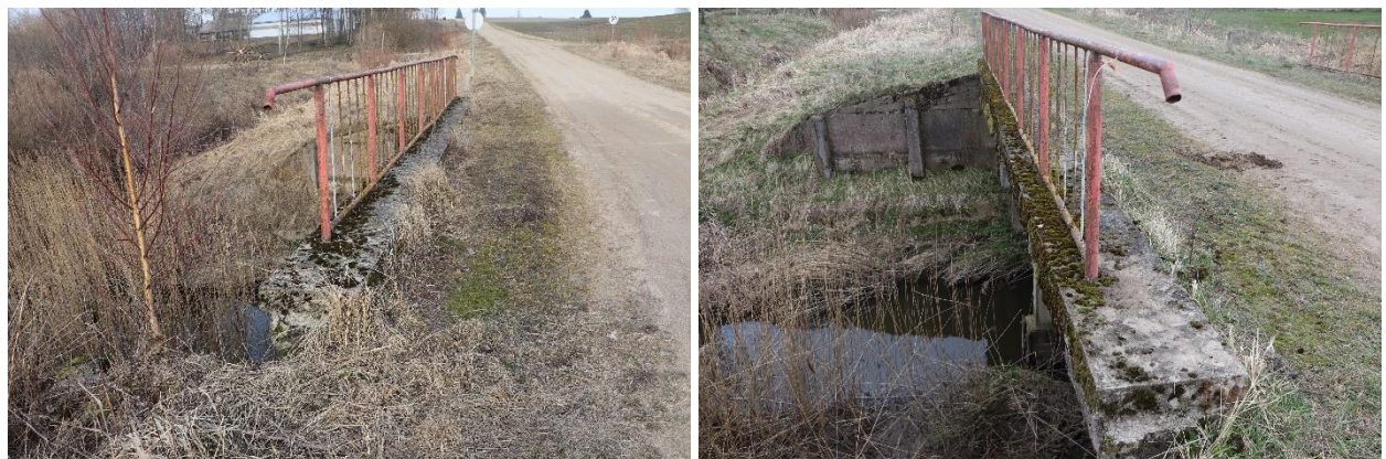
19 pav. Apsamoję, vietomis sudūlėję gelžbetoninių turėklinių blokų paviršiai
